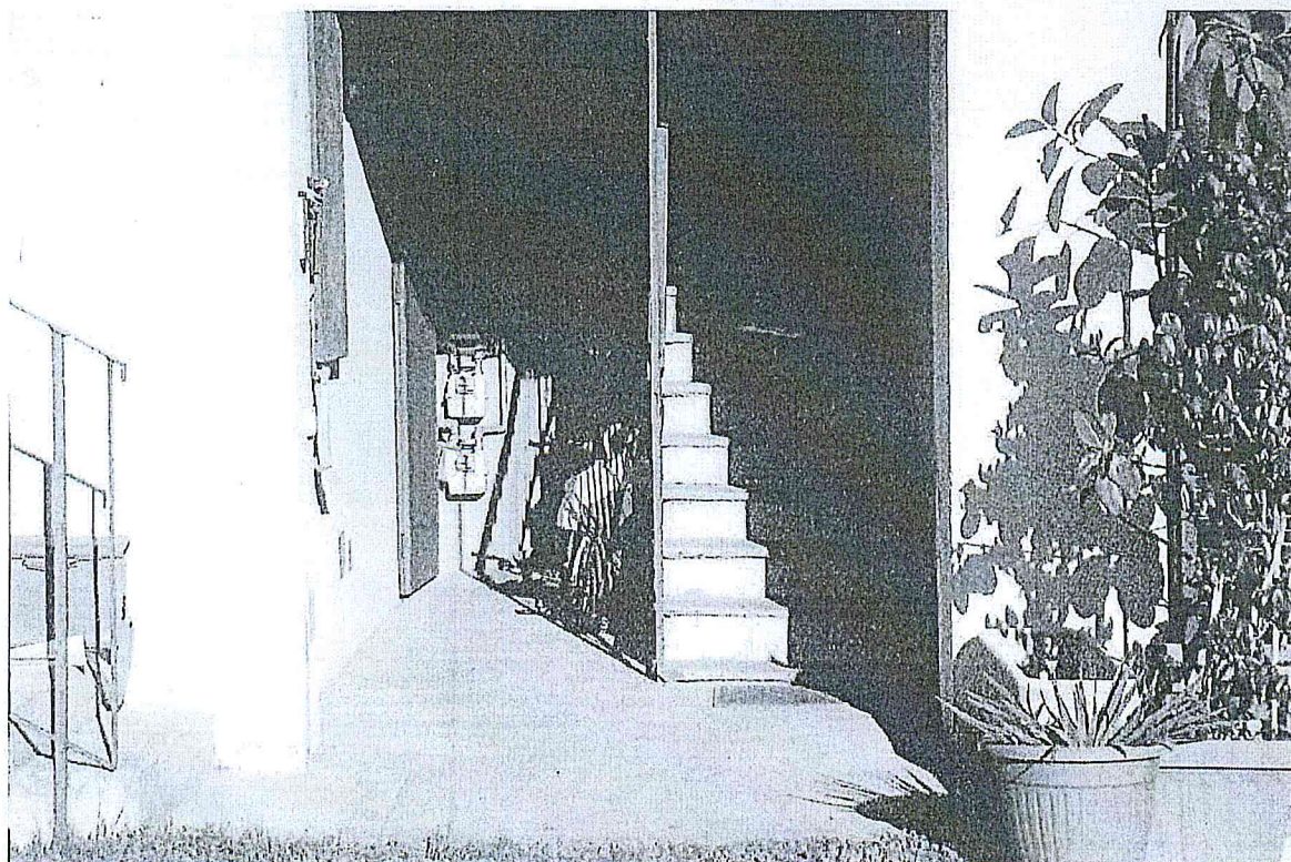
RGE 100/2012 Italfondiario S.p.A / Segepolam Raridite Arconate, Via IV Novembre 28, Foglio 4, mapp. 129 sub 704 graffato al mapp. 130 sub 704 Scale di accesso al ballatoio e prospetto dalla corte interna.
