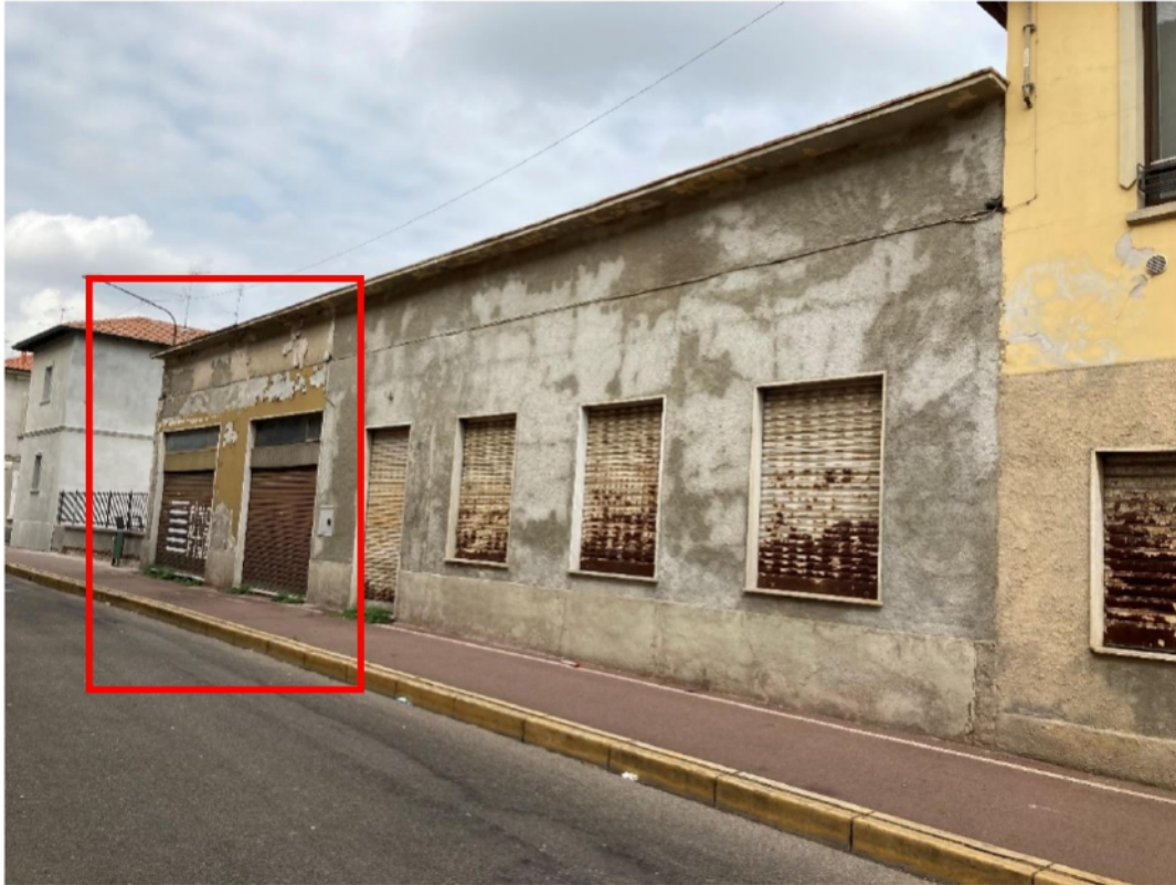
Foto n. 1: Prospetto principale su Via XXIV Maggio
