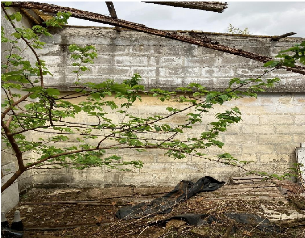
Foto n.12: ulteriore angolazione locale deposito.
