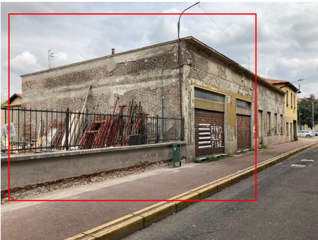
Foto n. 2: ulteriore vista prospetto su Via XXIV Maggio
