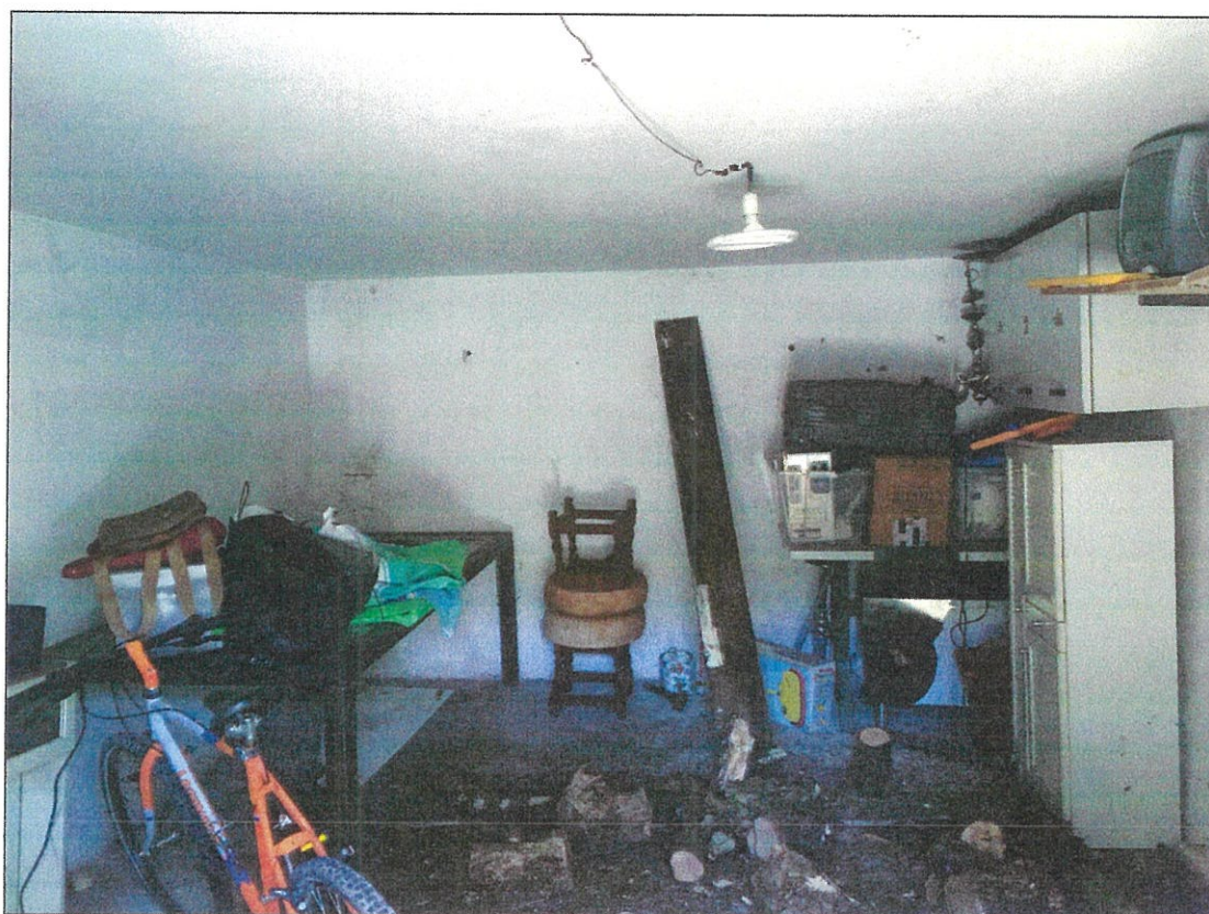
VISTA INTERNO MAGAZZINO
