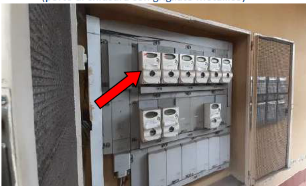
FOTO 35 - Vista interna armadietto contenente misuratori ENEL Condominio
