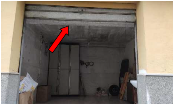
FOTO 31 –Serranda manuale avvolgibile con chiusura a chiave.
