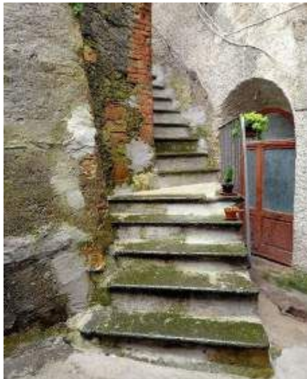
FOTOGRAFIA N° 2 Scala esterna comune
