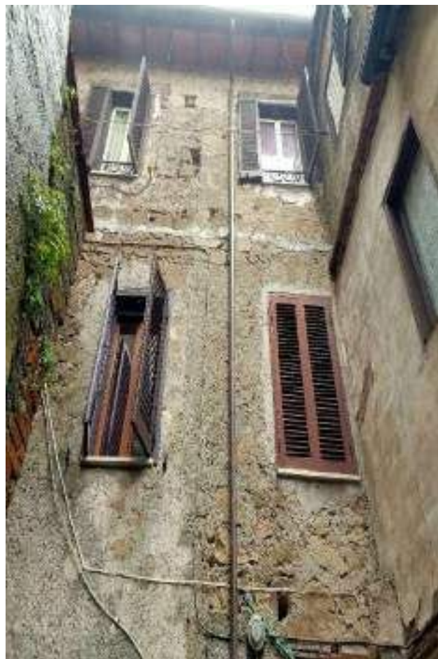
FOTOGRAFIA N° 4 Prospetto lato ingresso
