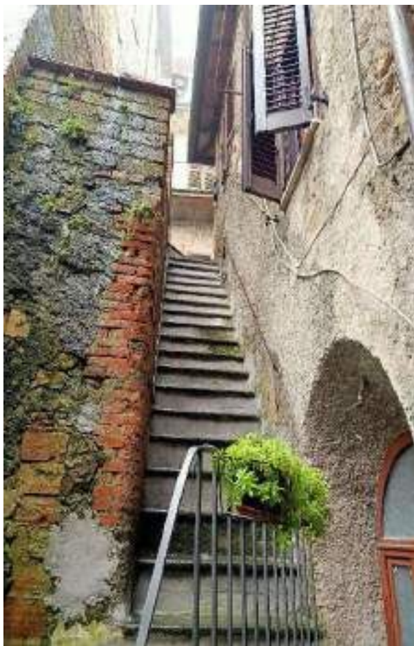
FOTOGRAFIA N° 3 Prospetto lato ingresso
