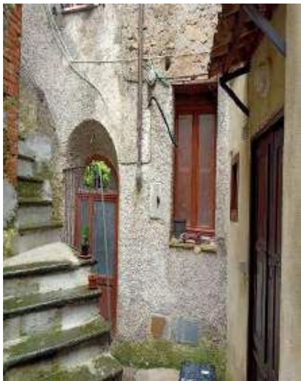
FOTOGRAFIA N° 1 Prospetto lato ingresso appartamento
