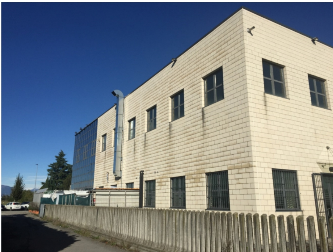
Foto 04 - Il fabbricato sul retro
