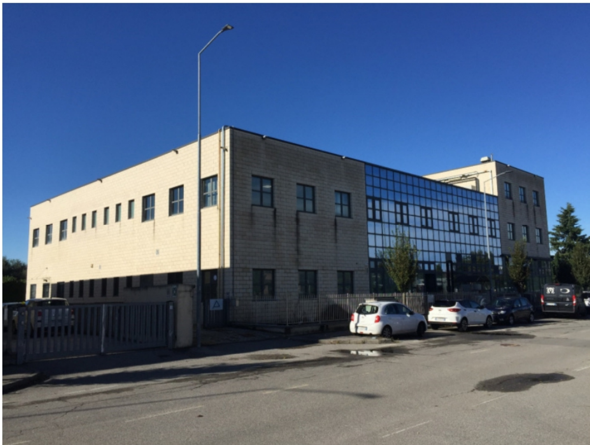
Foto 03 - Il fabbricato sul retro
