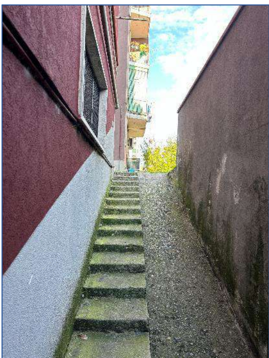
Foto 11 - spazi comuni accesso piano cantine
