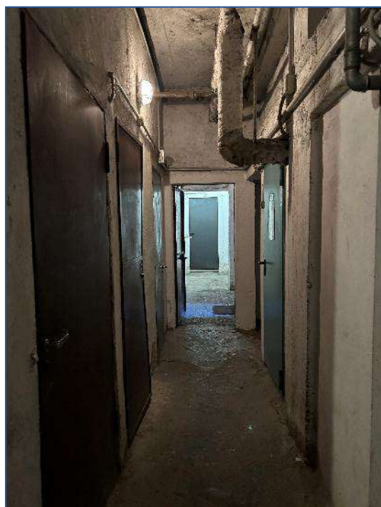
Foto 8 - spazi comuni piano cantine
