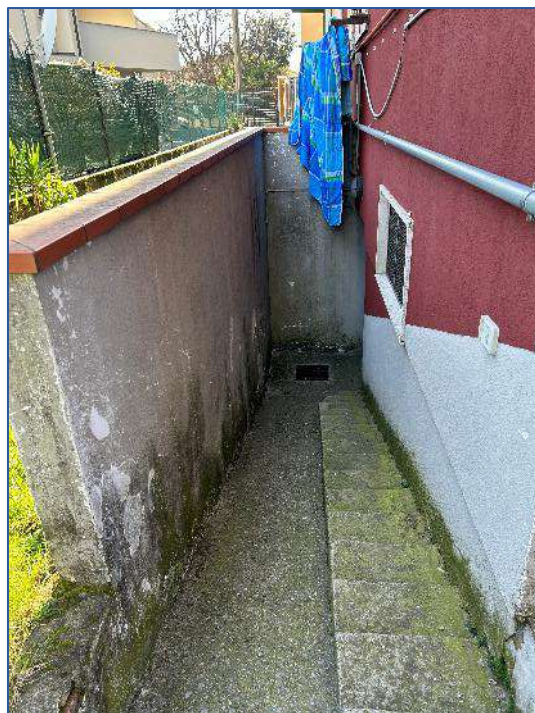
Foto 10 - spazi comuni accesso piano cantine
