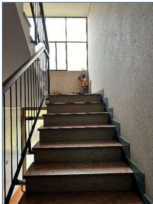
Foto 6 - vano scala comune
