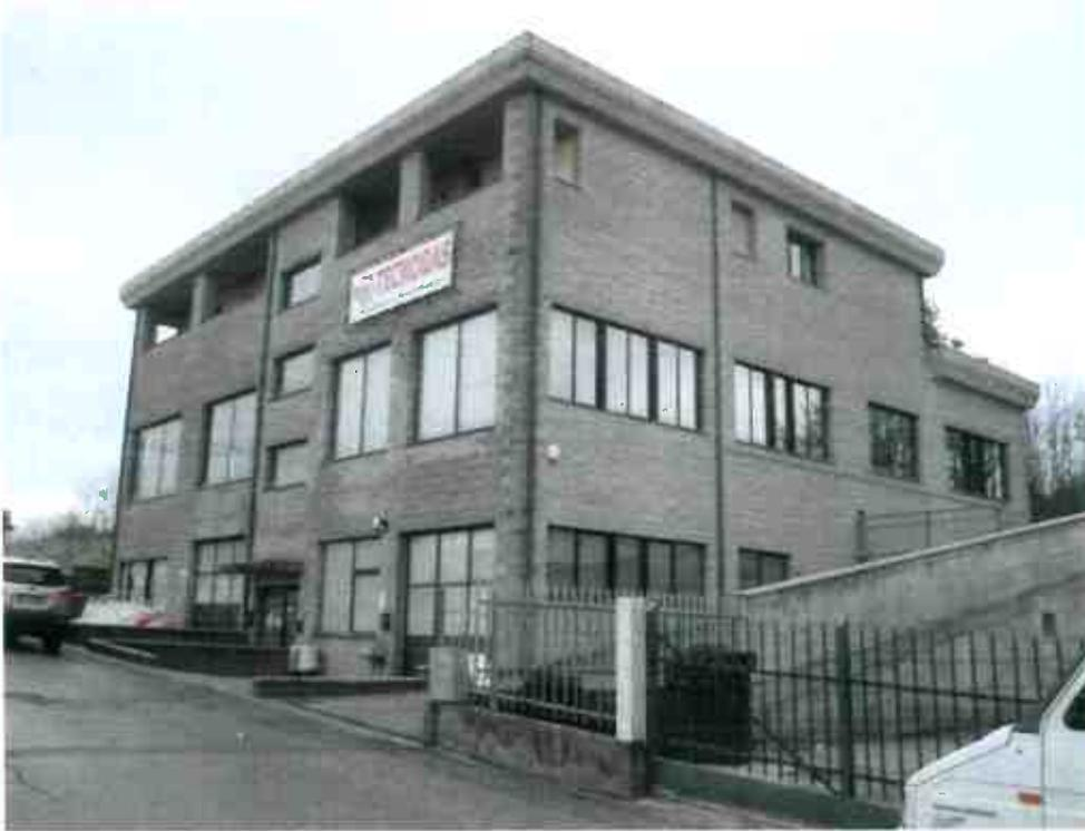
Le caratteristiche costruttive del fabbricato è con struttura portante in elevazione e orizzontale con intelaiatura in cemento armato, tamponature interne e esterne in laterizio e copertura a falde in una porzione e piana a terrazzo praticabile e non praticabile nell'altra porzione. I prospetti esterni sono rivestiti con rivestimento in simile pietra a vista ed hanno lineamenti semplici con finestre e porte non posizionate regolarmente.
