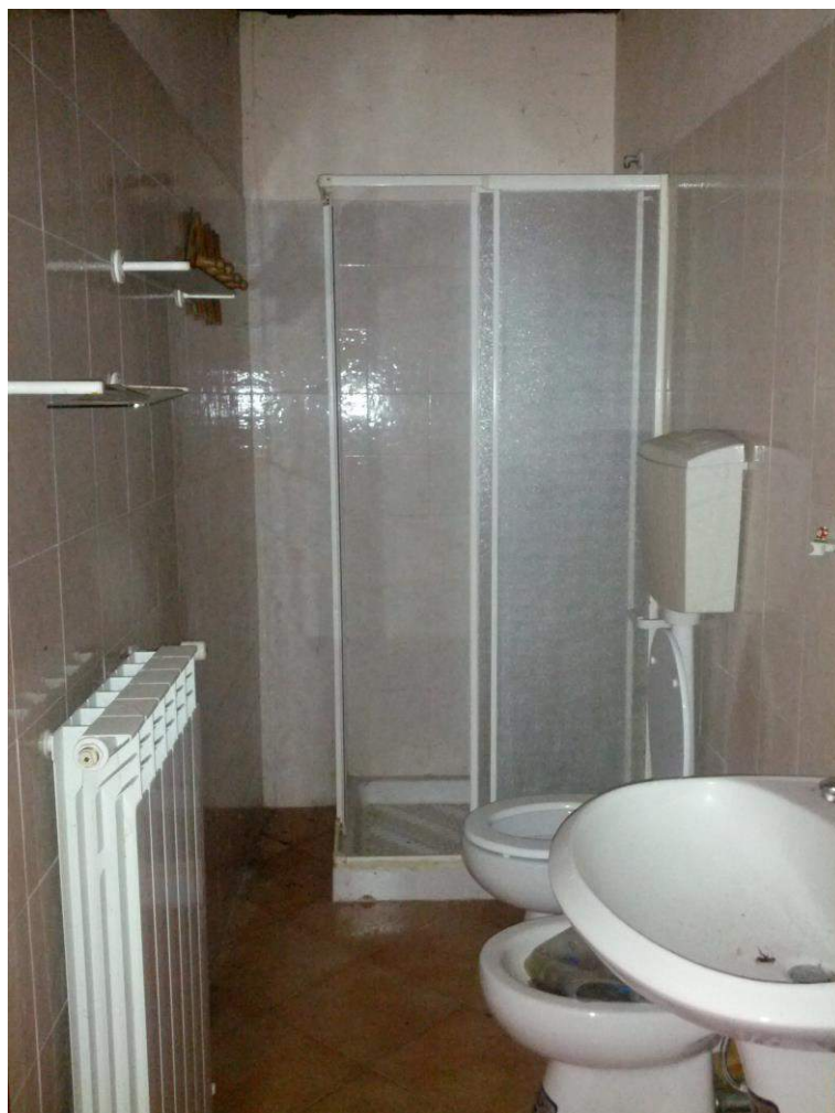
foto 22 – piano primo: servizi igienici
