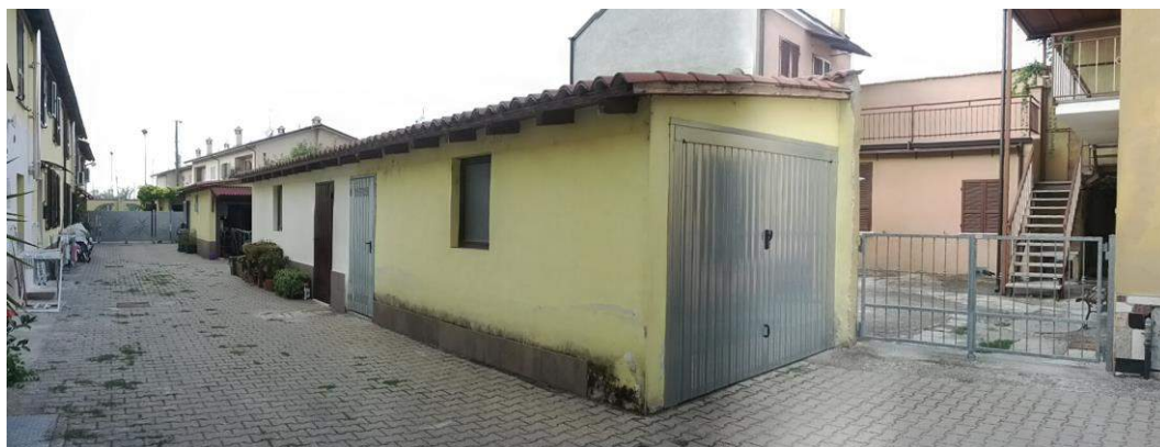
foto 06 – vista autorimessa da cortile comune
