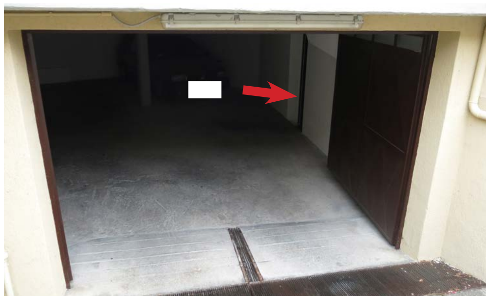
Rampa di accesso ai garage e alle cantine.
