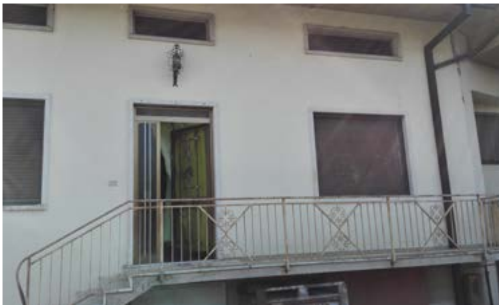
Ingresso, piano rialzato lotto 17.
