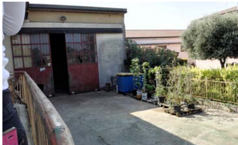
Deposito attrezzi piano terra lotto 17.
