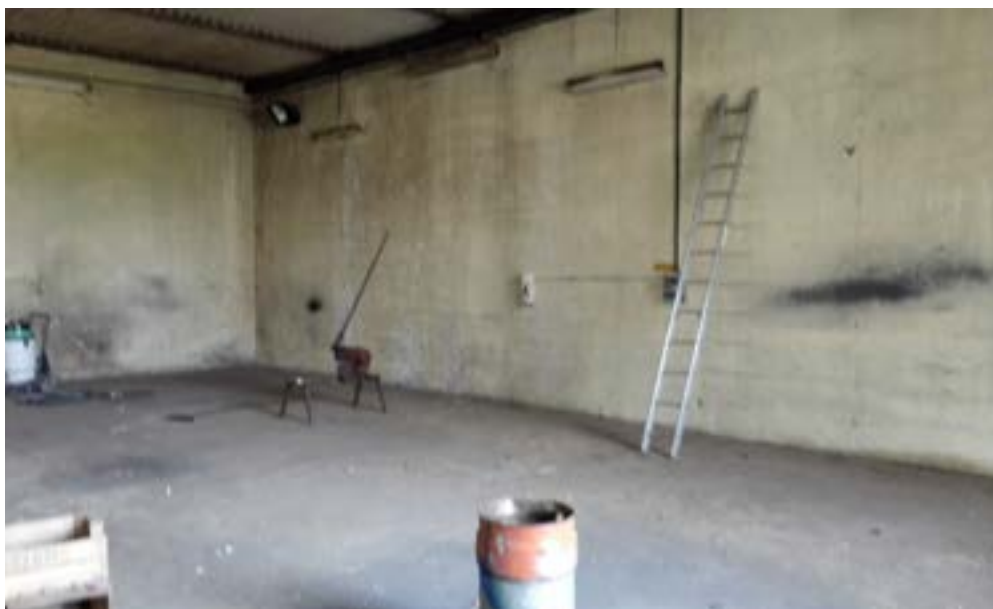
Deposito attrezzi, piano terra lotto 17.
