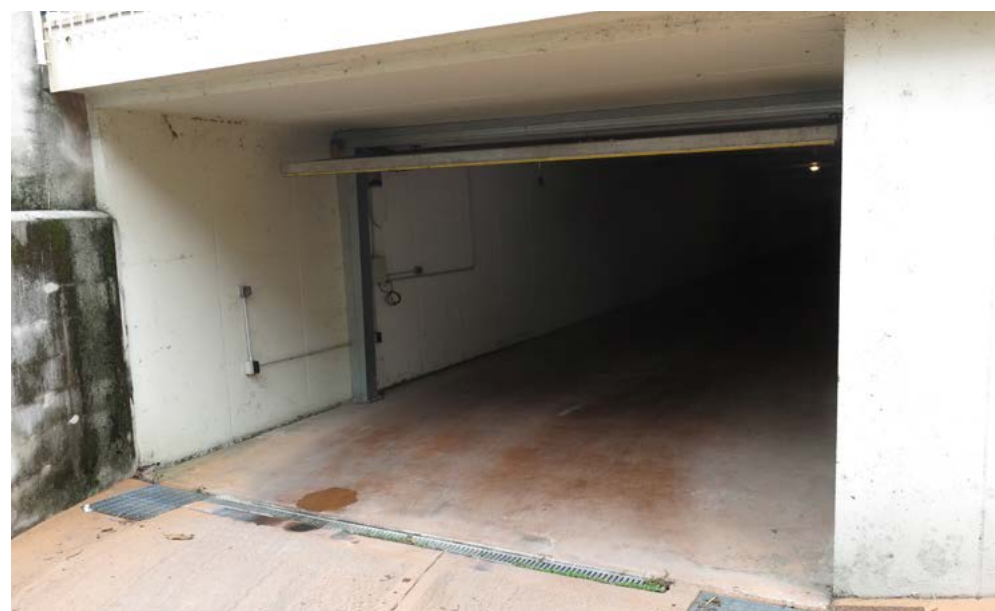
Ingresso garage, piano interrato.
