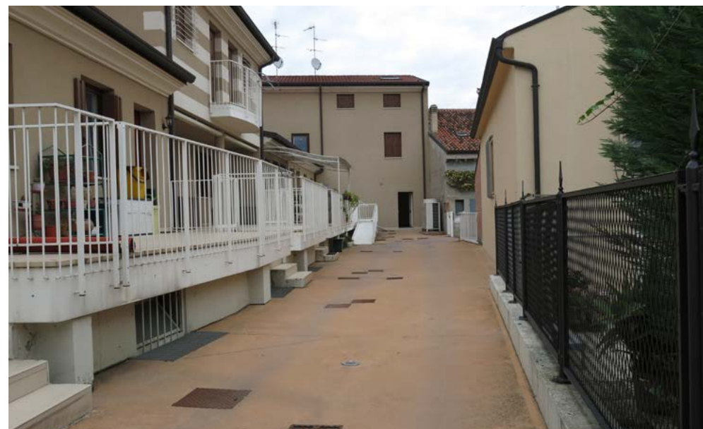
Passaggio carrabile, piano terra.
