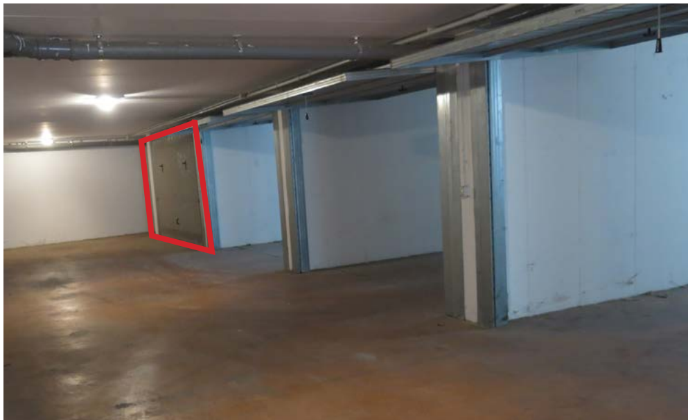
Area di manovra, piano interrato.
