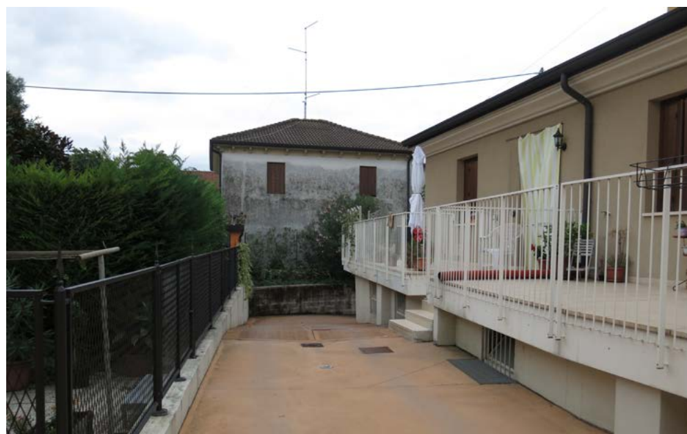
Corsia di accesso all'autorimessa.
