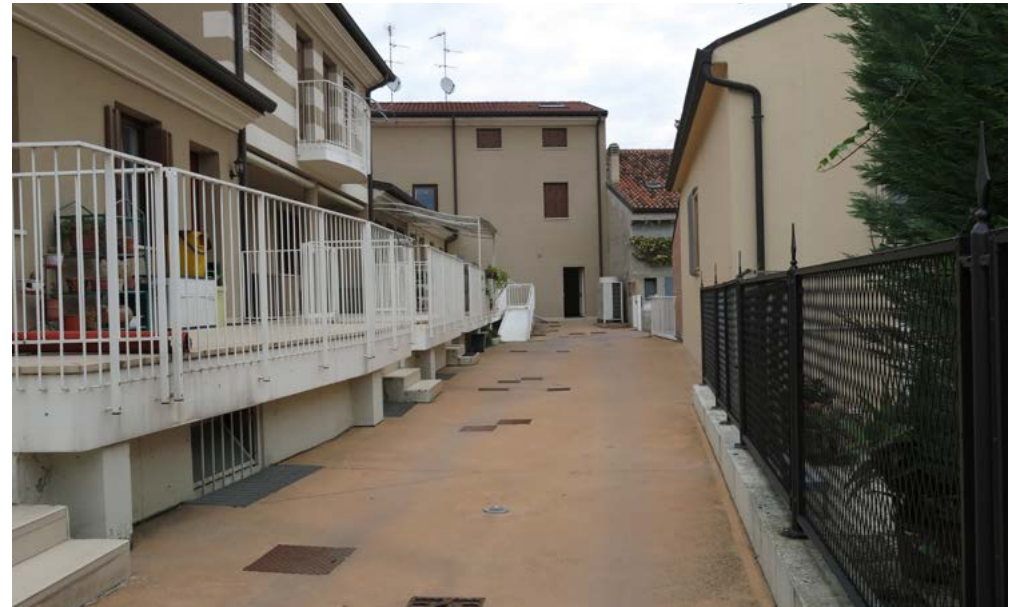
Passaggio carrabile, piano terra.
