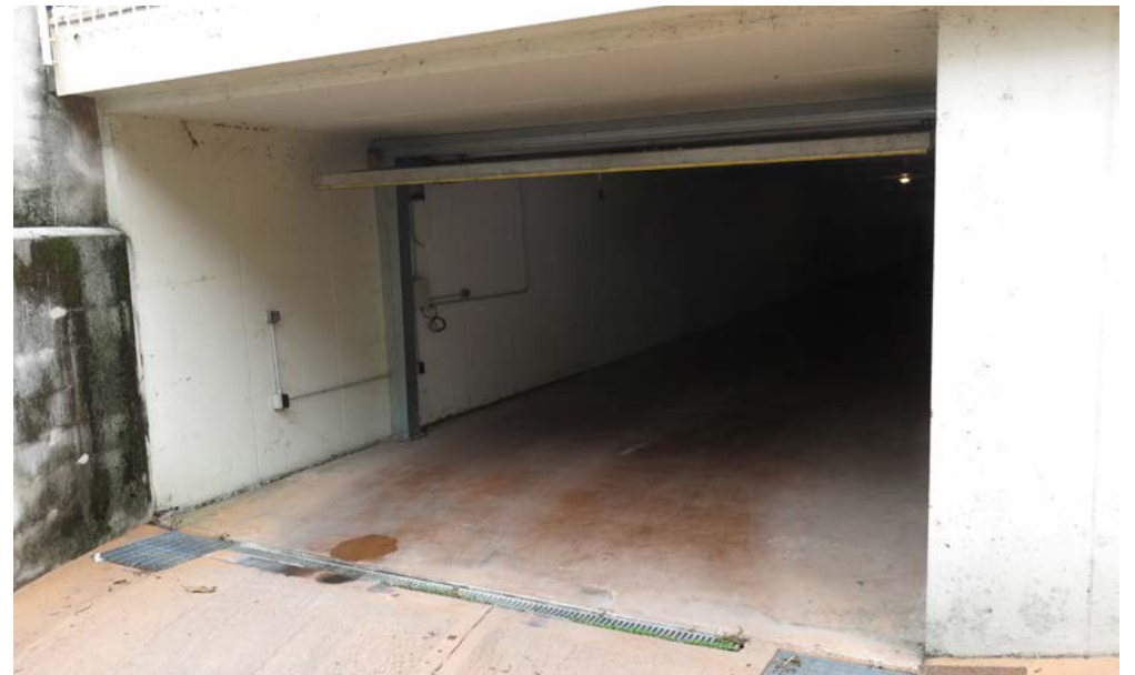
Ingresso garage, piano interrato.
