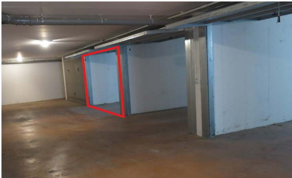
Area di manovra, piano interrato.
