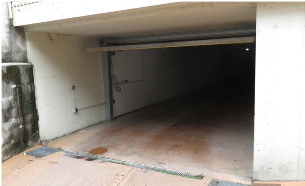
Ingresso garage, piano interrato.
