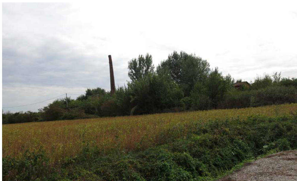
Fornace, vista da Est.
