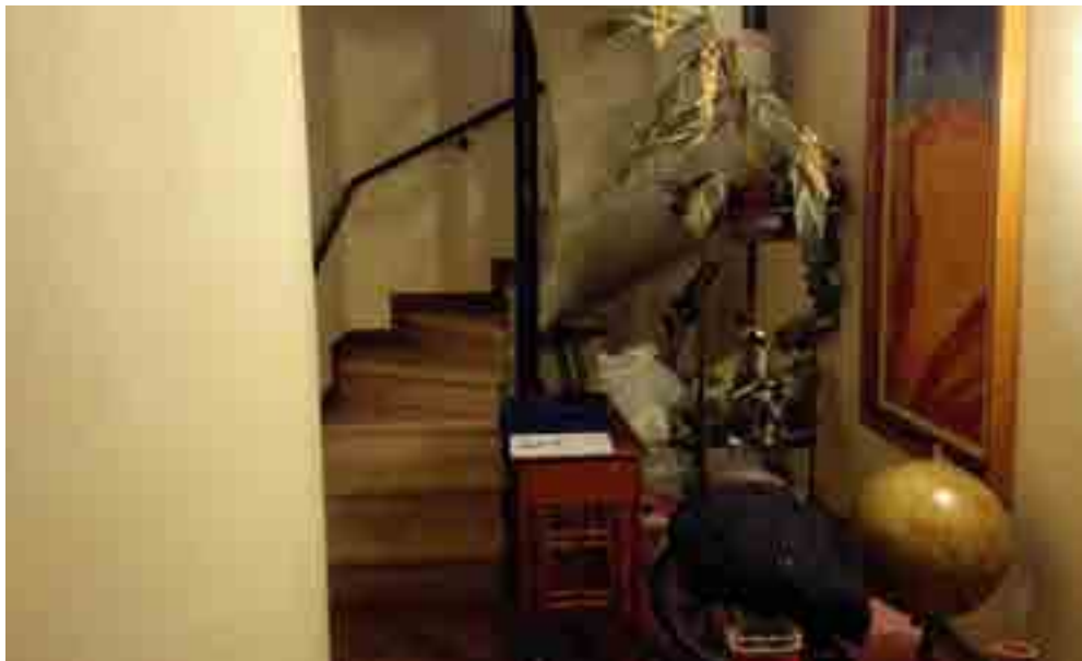
Scala che collega piano terra con piano primo, lotto 9.
