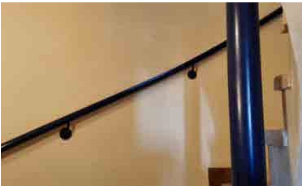
Scala che collega piano primo e secondo, lotto 9.
