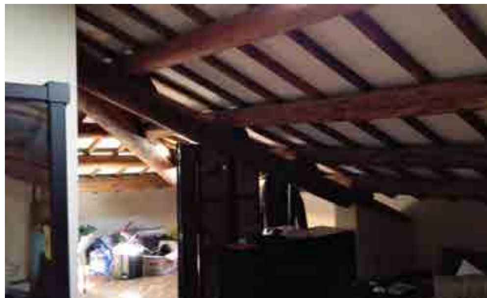
Sottotetto, piano secondo lotto 9.
