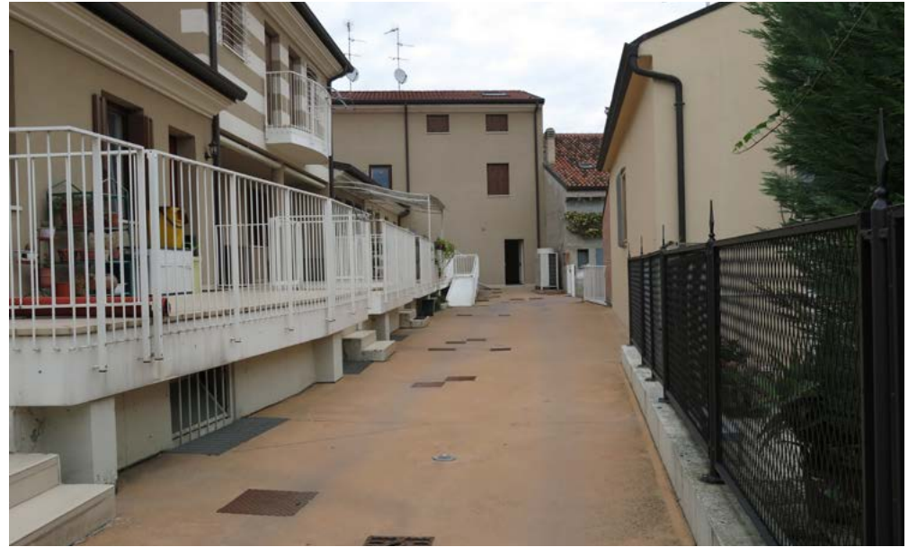
Passaggio carrabile, piano terra.
