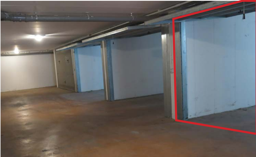
Area di manovra, piano interrato.
