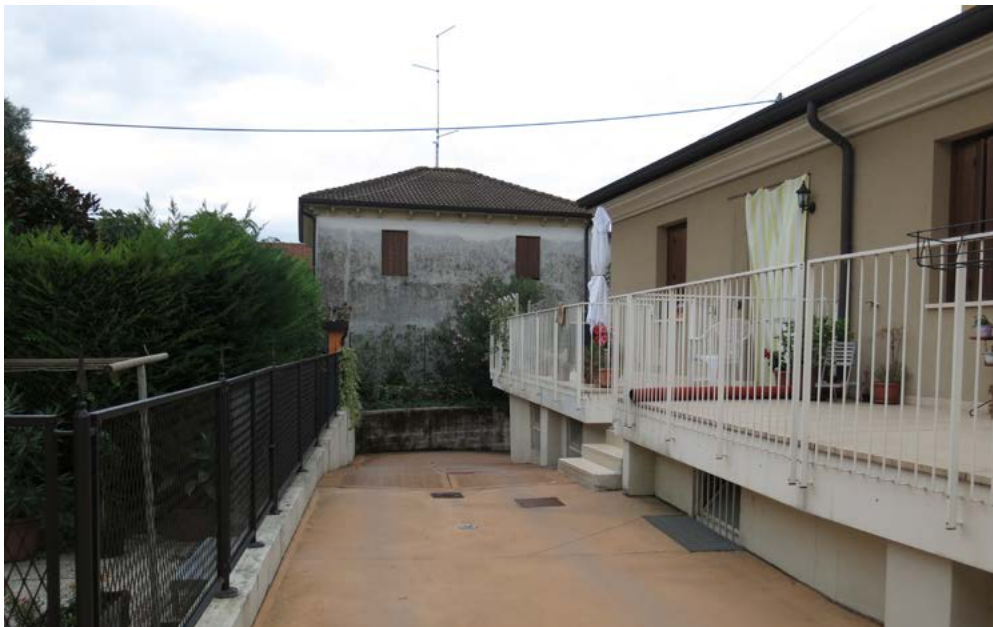
Corsia di accesso all'autorimessa.
