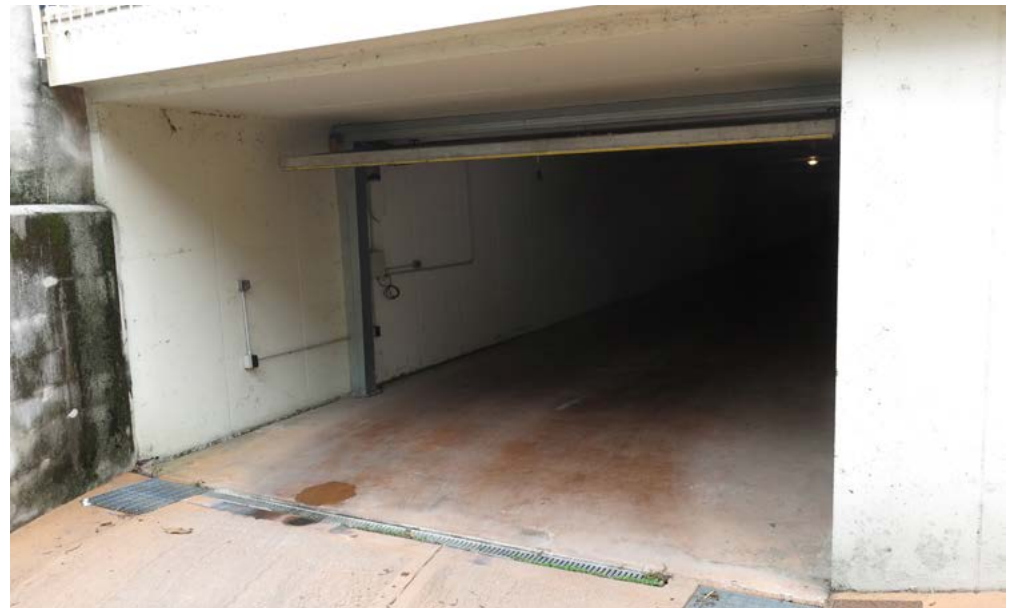
Ingresso garage, piano interrato.
