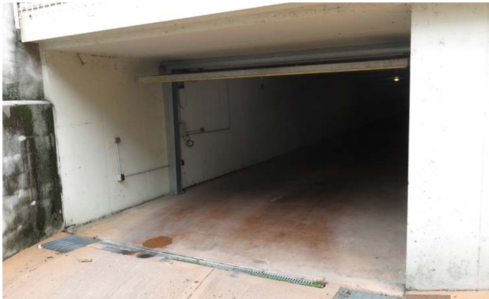
Ingresso garage, piano interrato.
