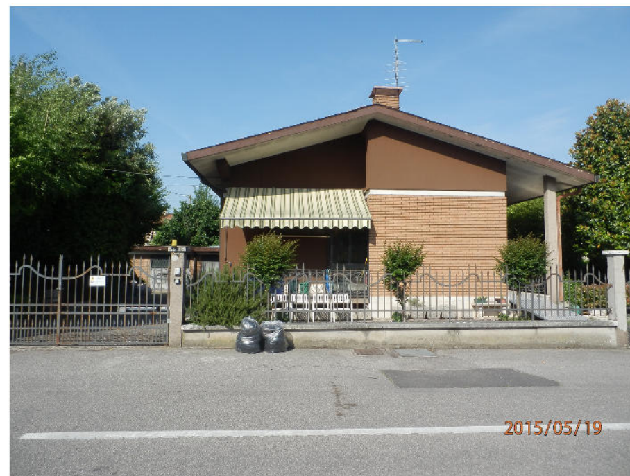
02 vista esterna dell'ingresso da via Gorizia
