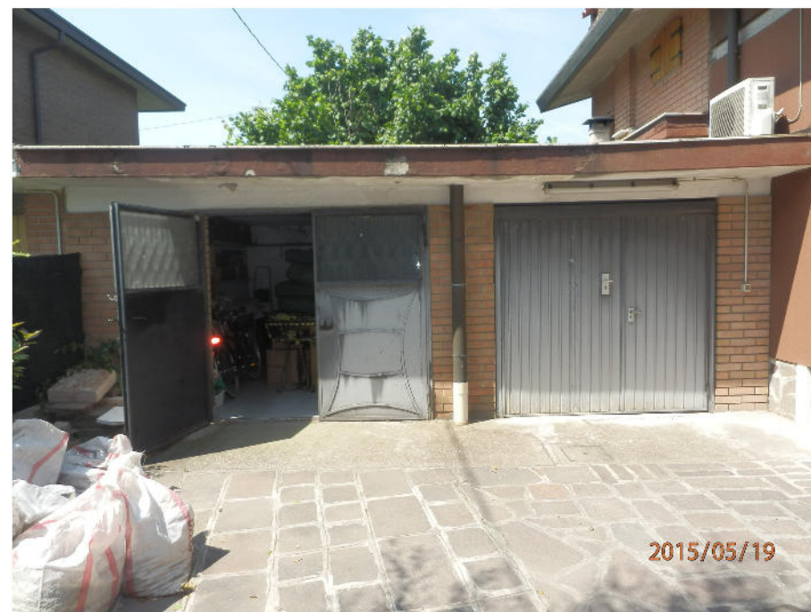
04 vista esterna delle autorimesse sul lato sud
