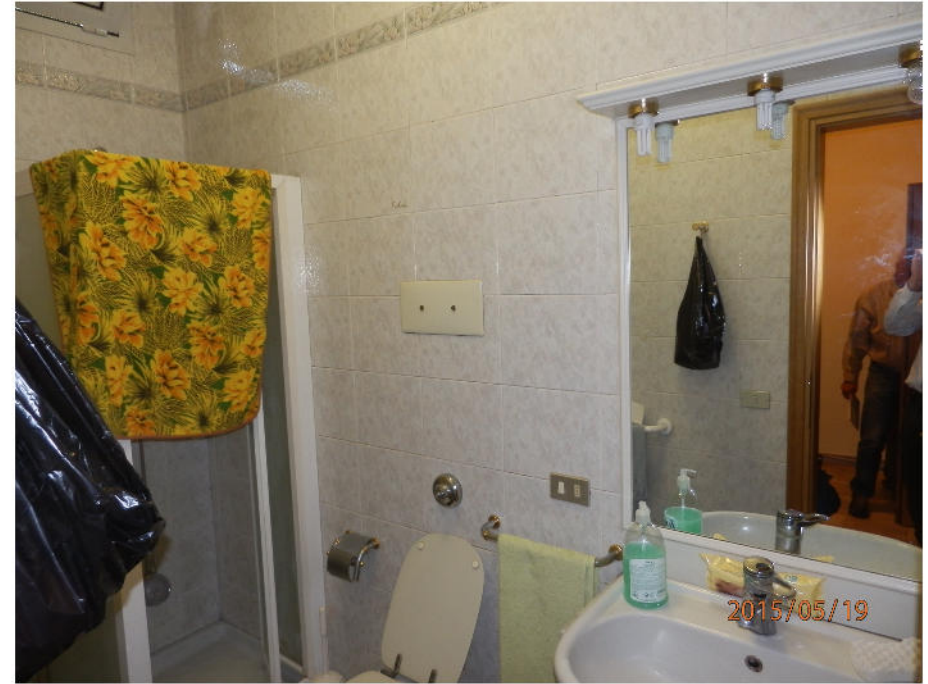
14 vista interna del bagno (ampliam.) PT
