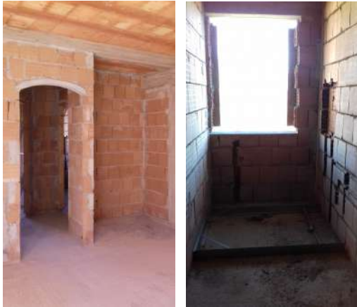
Interno unità p.lla 644 sub 3
