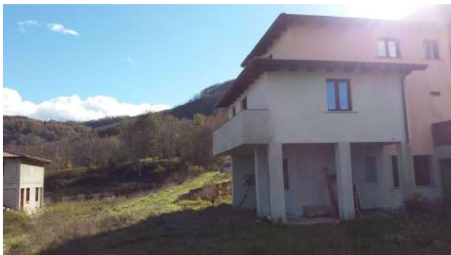
Ingressi unità p.lle 642 sub 1 e sub 2
