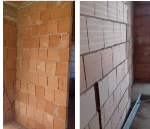
Interno unità p.lla 644 sub 4
