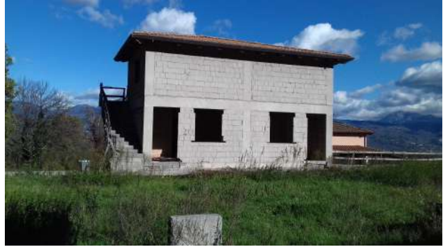
Ingressi unità p.lle 643 sub 5, sub 4 e sub 3
