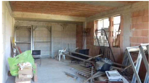
Interno unità p.lla 643 sub 1
