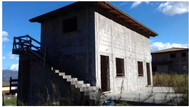
Ingressi unità p.lle 646 sub 5, 4 e 3
