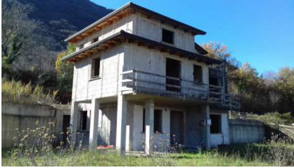
Ingressi unità p.lle 646 sub 1 e 2
