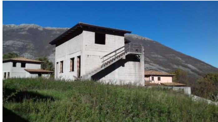
Ingressi unità p.lle 644 sub 5, sub 4 e sub 3
