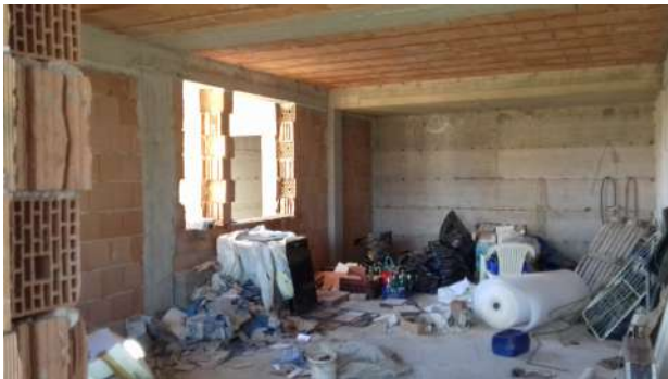
Interno unità p.lla 643 sub 2
