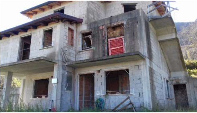
Ingressi unità p.lle 648 sub 1 e sub 2
