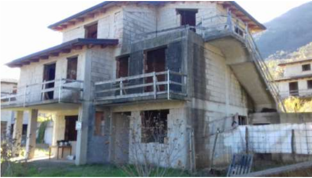
Ingressi unità p.lle 643 sub 1 e sub 2
