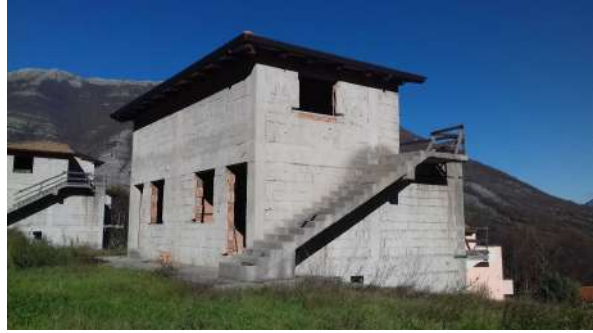
Ingressi unità p.lle 645 sub 5, 4 e 3
