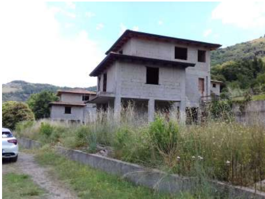
Ingressi unità p.lle 644 sub 1 e sub 2
