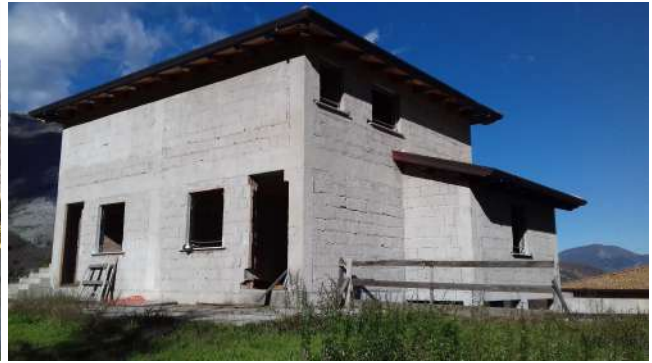
Ingressi unità p.lle 648 sub 3, sub 4 e sub 5
