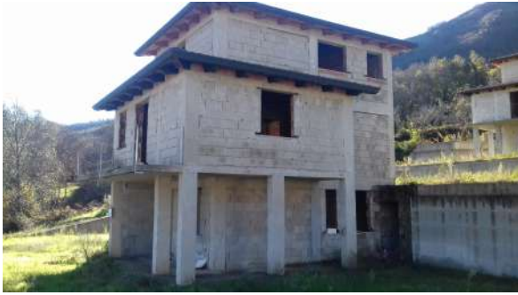
Ingressi unità p.lle 645 sub 1 e 2
