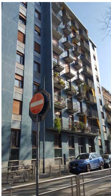
VIA DEZZA, 25 - FRONTE
