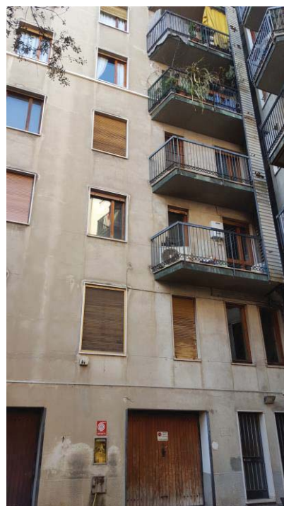
FACCIATA SU CORTILE INTERNO
