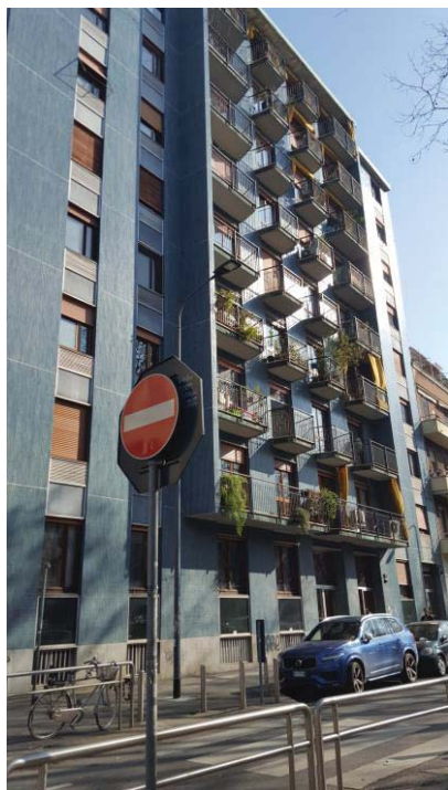
VIA DEZZA, 25 - FRONTE
