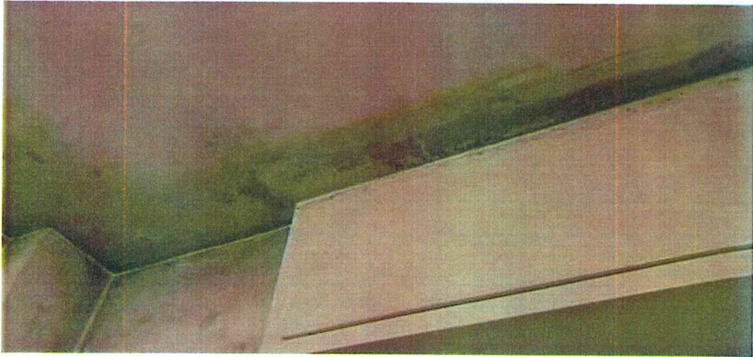
Fotografia G.11 - Ponte termico corrispondenza solaio
