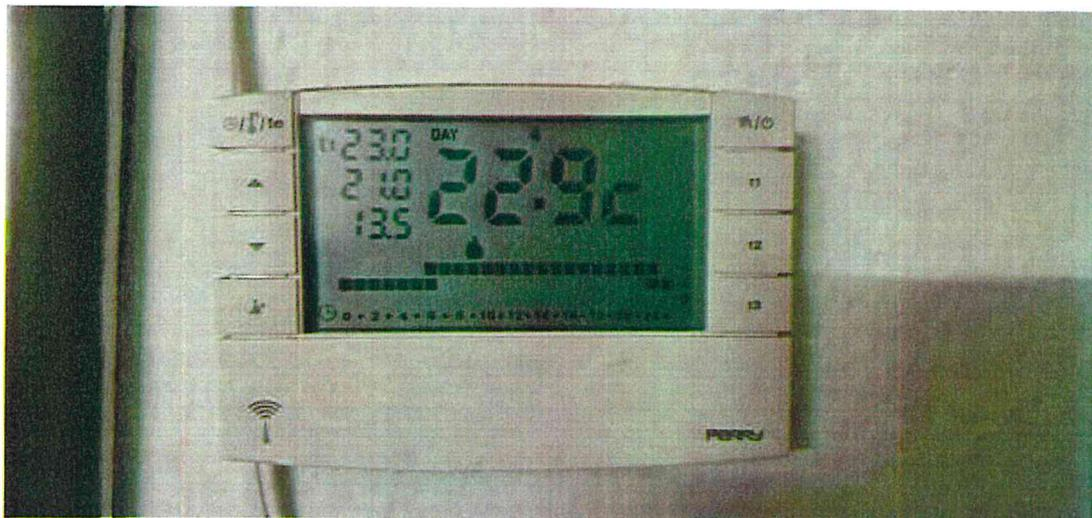
Fotografia G.12 - Termostato con temperature ben oltre la norma
