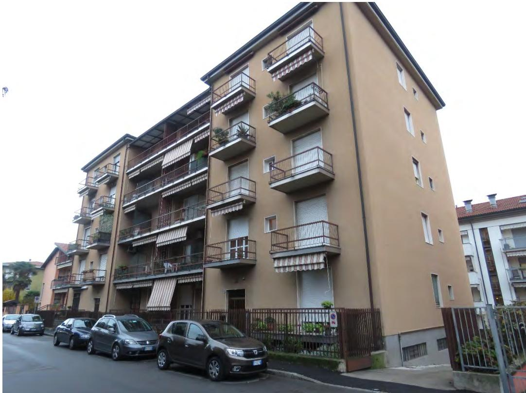
Come più sopra detto il fabbricato è stato realizzato nei primi anni del 1960 con sistema edilizio a struttura intelaiata in calcestruzzo armato e tamponamenti e orizzonti in latero/cemento e con tipologia tipica dell'epoca con finiture di tipo economico (ved. foto in alto).
