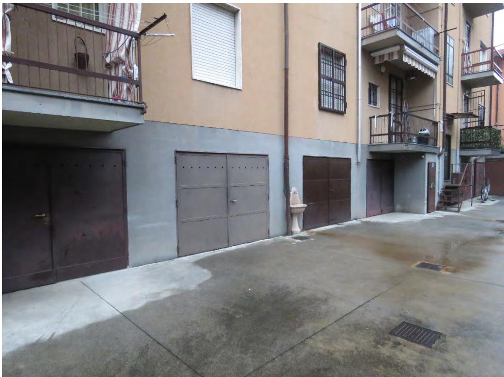
Come più sopra detto il fabbricato è stato realizzato nei primi anni del 1960 con sistema edilizio a struttura intelaiata in calcestruzzo armato e tamponamenti e orizzonti in latero/cemento e con tipologia tipica dell'epoca con finiture di tipo economico.
