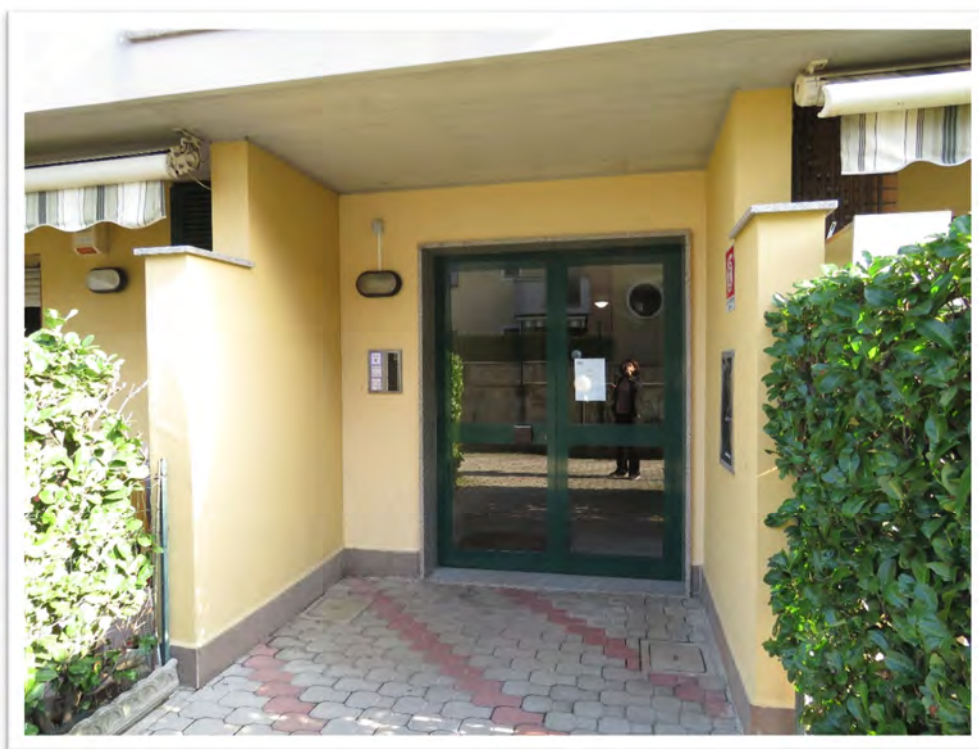
Particolare dell'ingresso condominiale alla scala "B".
