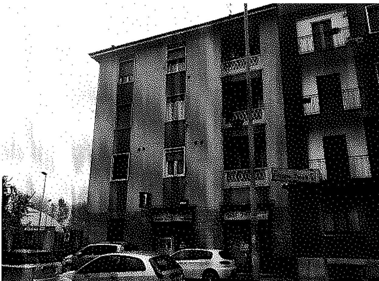
Trattasi di costruzione risalente come si è visto all'inizio degli anni '50 del secolo scorso costruita con struttura intelaiata in calcestruzzo armato e muratura con solai e tamponamenti in latero-cemento.
