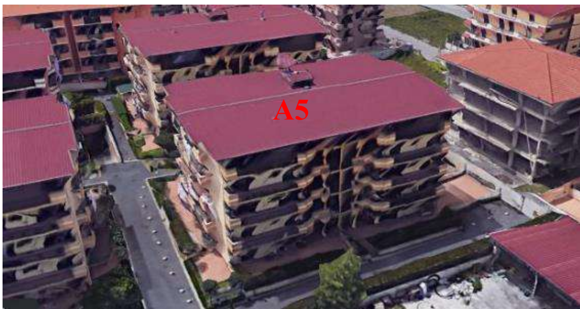
Vista dall'alto del fabbricato A5 di cui l'appartamento e il box auto pertinenziale pignorato sono parte integrante
