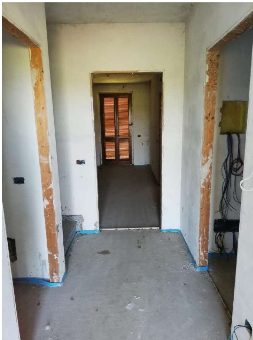
2.16 Vista interna LOTTO 1 - Villetta nord - ingresso piano terra
