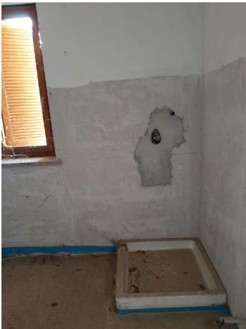
2.32 Vista interna LOTTO 2 - Villetta centrale – bagno piano terra
