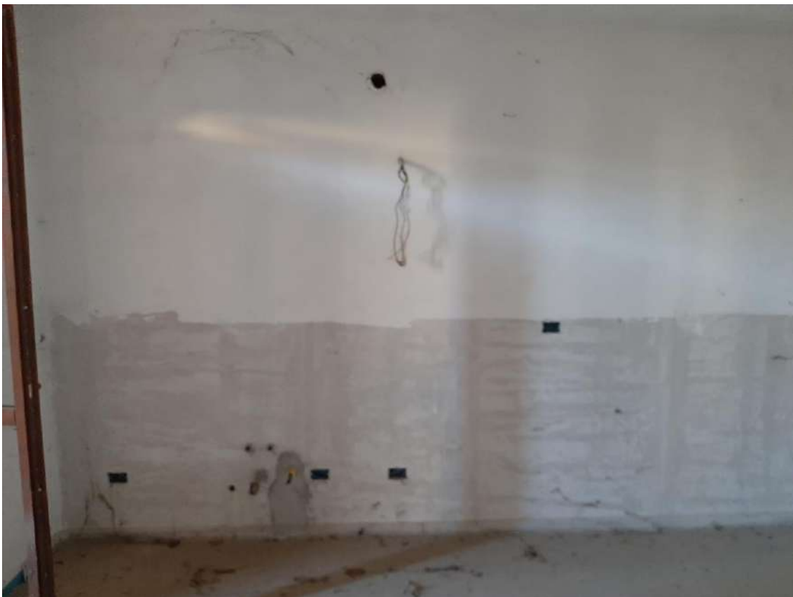
2.31 Vista interna LOTTO 2 - Villetta centrale – cucina piano terra
