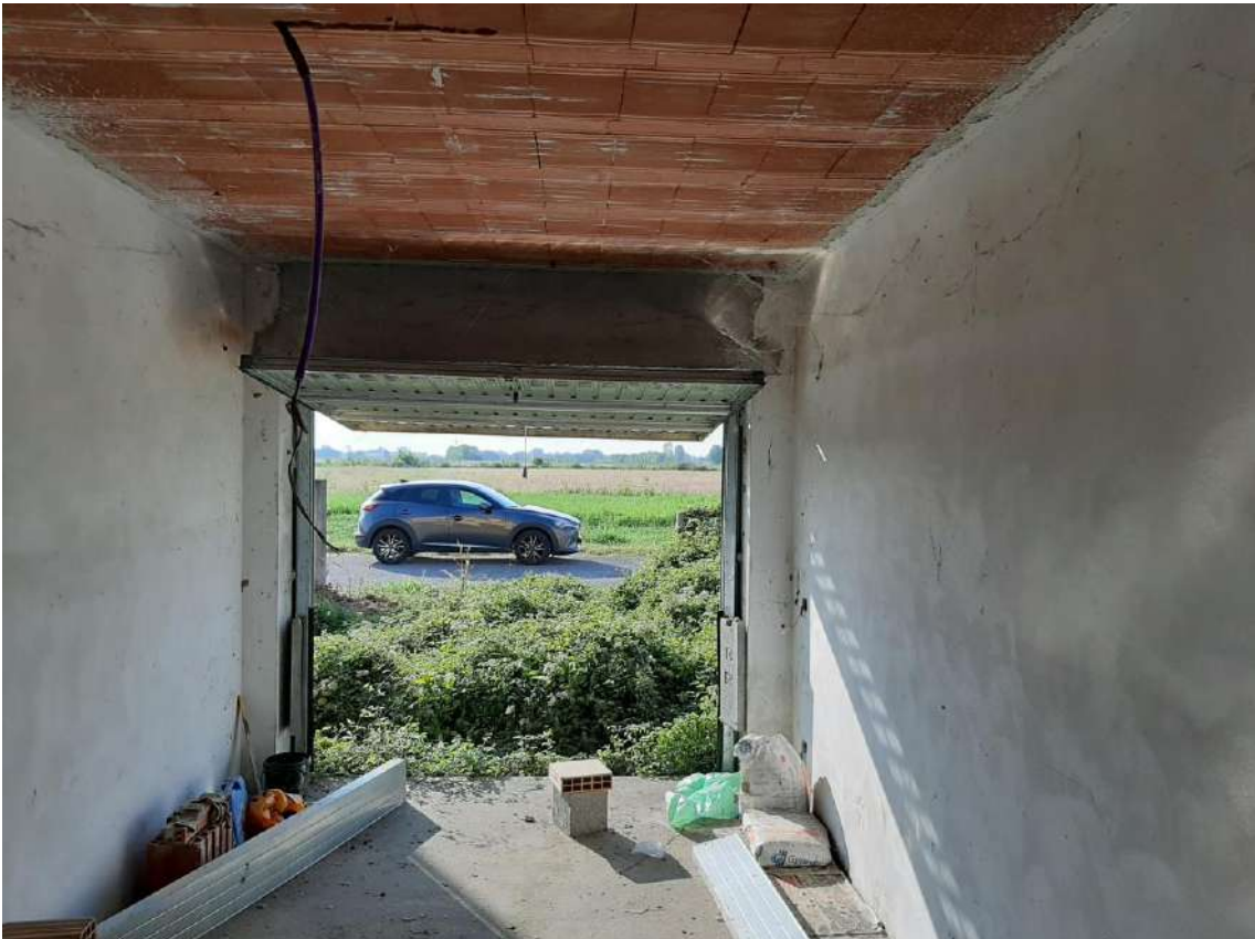
2.51 Vista interna LOTTO 3 - Villetta sud – Autorimessa piano terra
