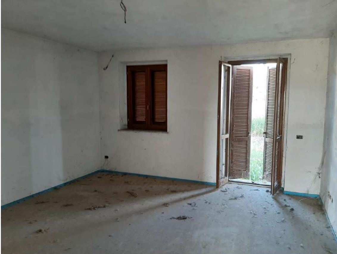
2.30 Vista interna LOTTO 2 - Villetta centrale – soggiorno piano terra
