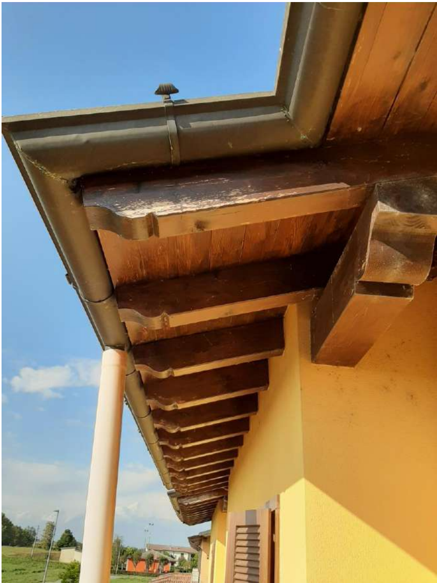
2.39 Vista LOTTO 2 - Villetta centrale – particolare gronda in legno
