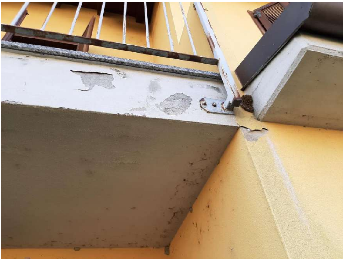
2.40 Vista LOTTO 2 - Villetta centrale – particolare soletta balcone
