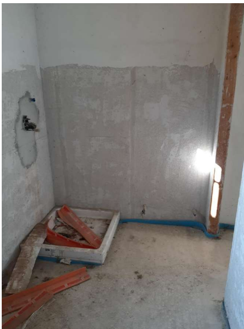
2.19 Vista interna LOTTO 1 - Villetta nord - bagno piano terra
