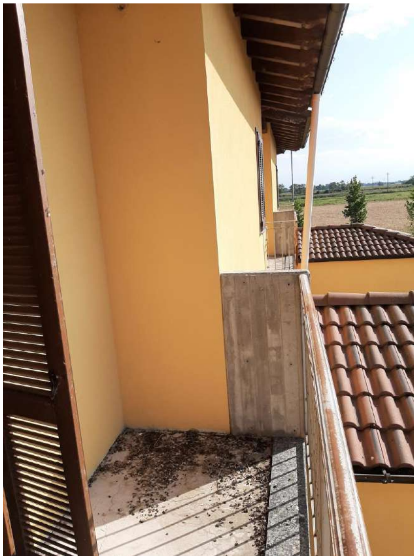
2.24 Vista interna LOTTO 1 - Villetta nord – balcone piano primo
