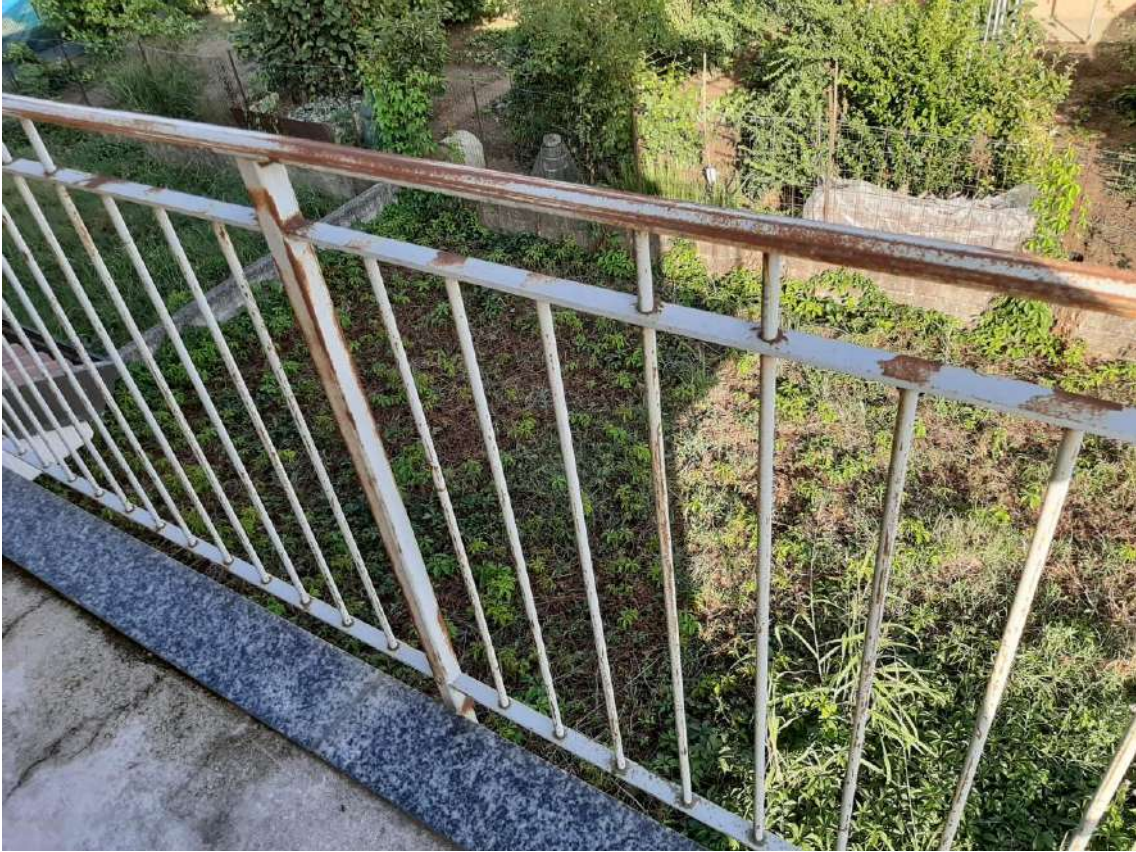
2.50 Vista LOTTO 3 - Villetta sud – Particolare parapetto balcone piano primo
